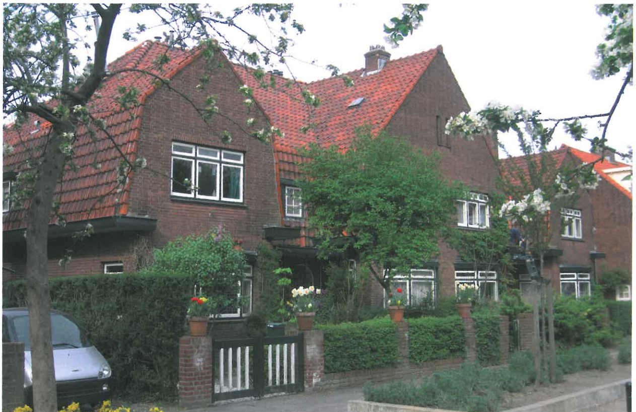
De Kempeneerstraat 3-9, woningbouw uit de jaren twintig.
