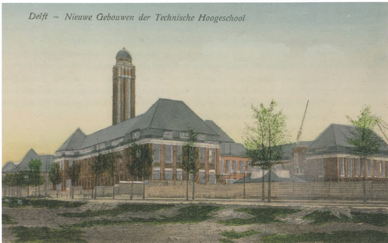
Julianalaan, Rode Scheikunde, voormalig hoofdgebouw van de Technische Hogeschool, herbestemming tot appartementencomplex.
