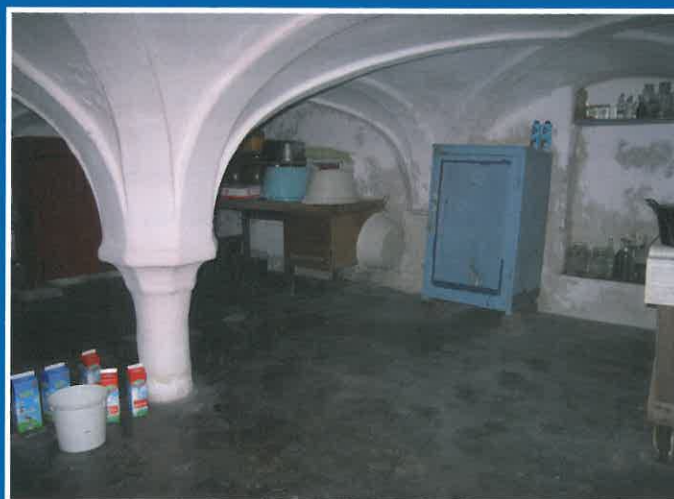
Rotterdamseweg, woning bij Hammenpoort, overwelfde kelder.
