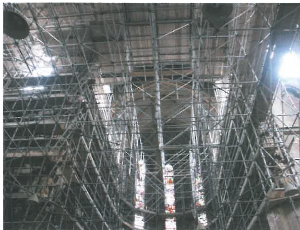
Kostbaar steigerwerk in de Maria van Jessekerk, tijdens de restauratie van het interieur.
