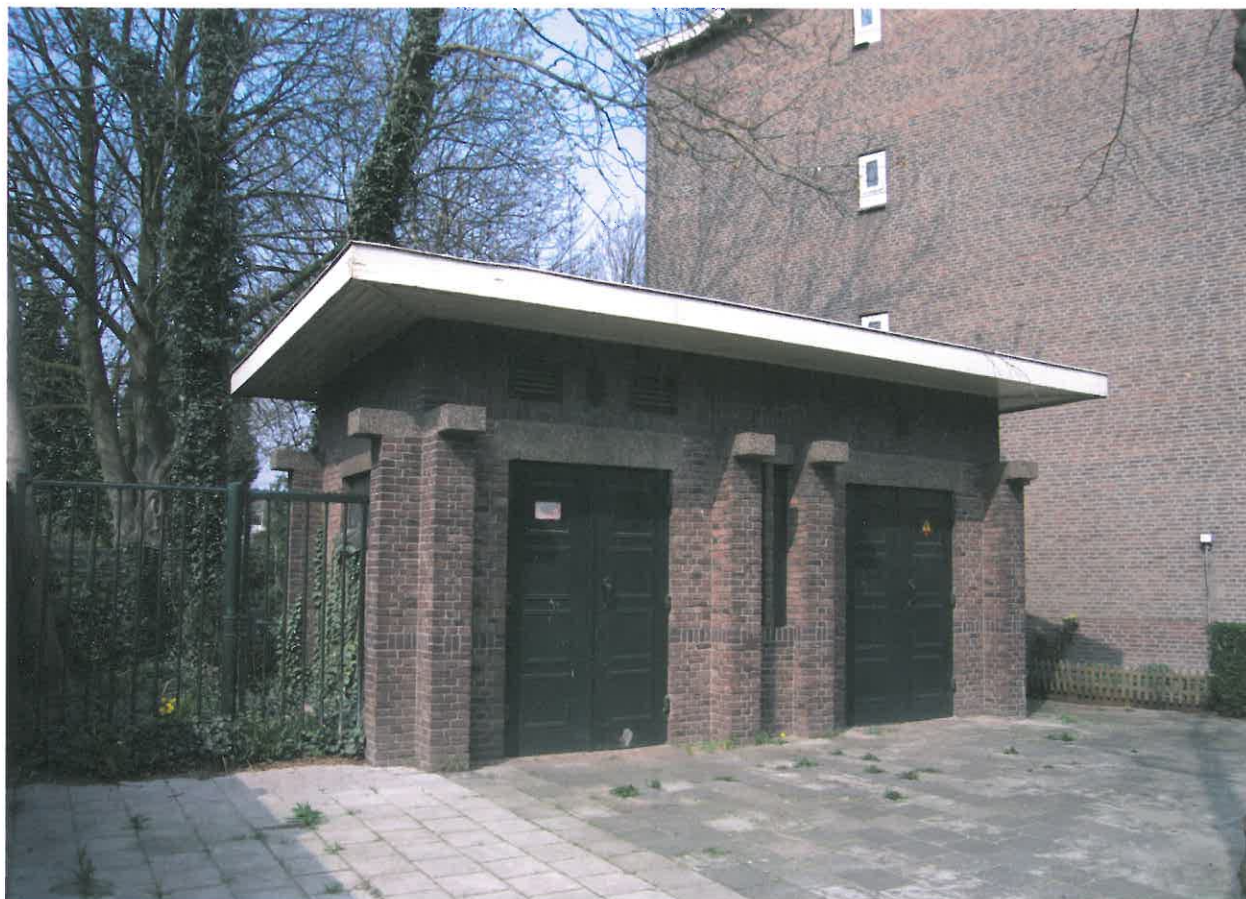
Trafohuisje aan de Willem van Aelststraat.
