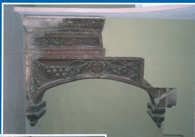
Markt 30, gesneden boog boven toegang naar kelder.
