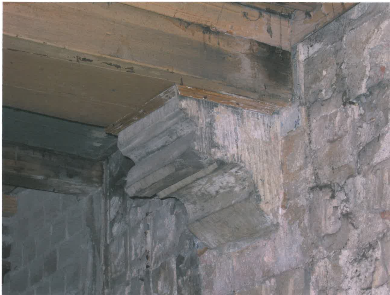
Markt 30, achterhuis, laatgotische balkconsole in kelder.
