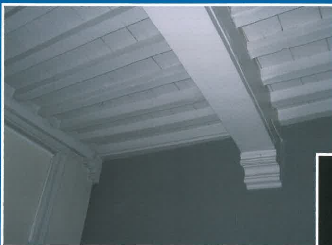
Koornmarkt 69, laatgotische balklaag met consoles.
