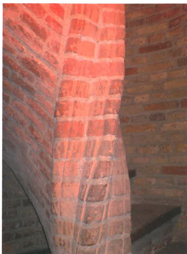
Metselwerk in traptoren Museum Het Prinsenhof
