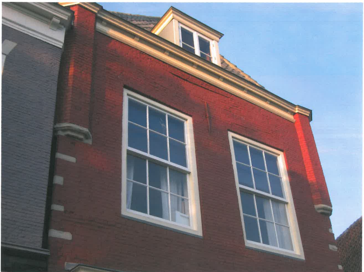
Oosteinde 173, roodgeschilderde laatgotische gevel.
