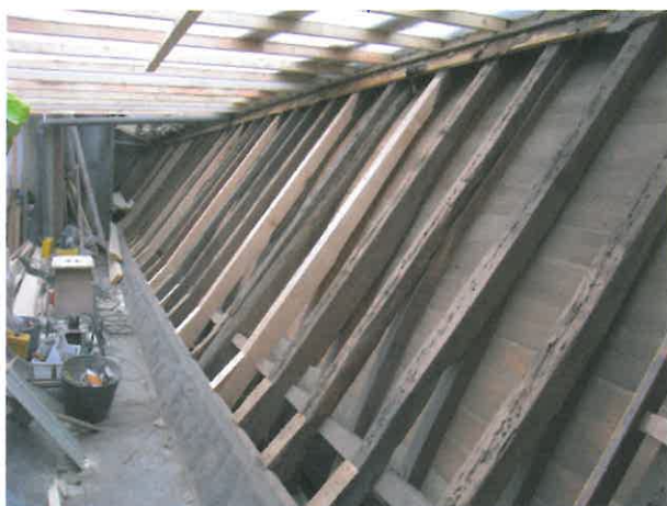
Lutherse kerk, werk in uitvoering aan het dak tijdens de restauratie.
