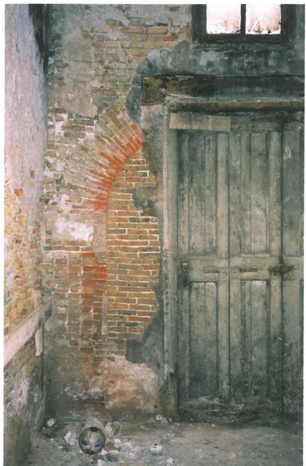
Molenstraat 11, voormalige zeepfabriek Bousquet, bouwspoor in metselwerk.
